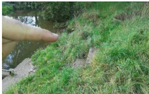
Obr. 5.2.9 Zlonický potok pohled proti proudu z levého břehu na vtok do odběrného obj. Zásobní nádrže Kobylníky
