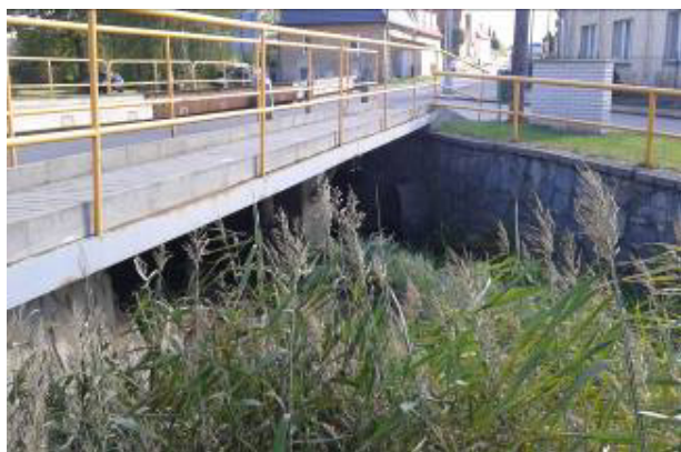
Obr. 5.2.18 Žerotínský potok, silniční most, hlásný profil C-M3_ŽR, ř. km 0,62.
