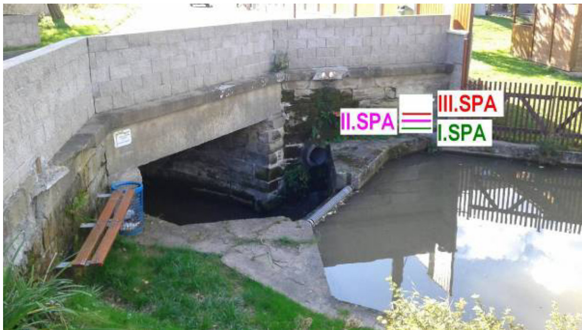
Obr. 3.9 Umístění značek stupňů povodňové aktivity na Skalském potoce v profilu mostu z návodní strany. Stanoveno na základě hydraulických výpočtů.
