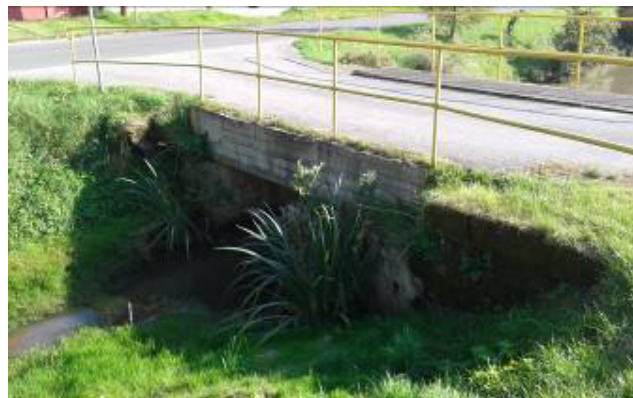
Obr. 5.2.32 Skalský potok, most M6_SK v ř. km 0,685. Pohled z pravého břehu na vtokové čelo mostu.
