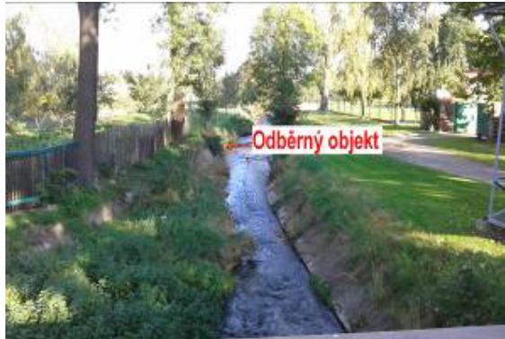
Obr. 5.2.1 Zlonický potok pohled po proudu z mostu C-M1_ZL, ř. km 13,50.
