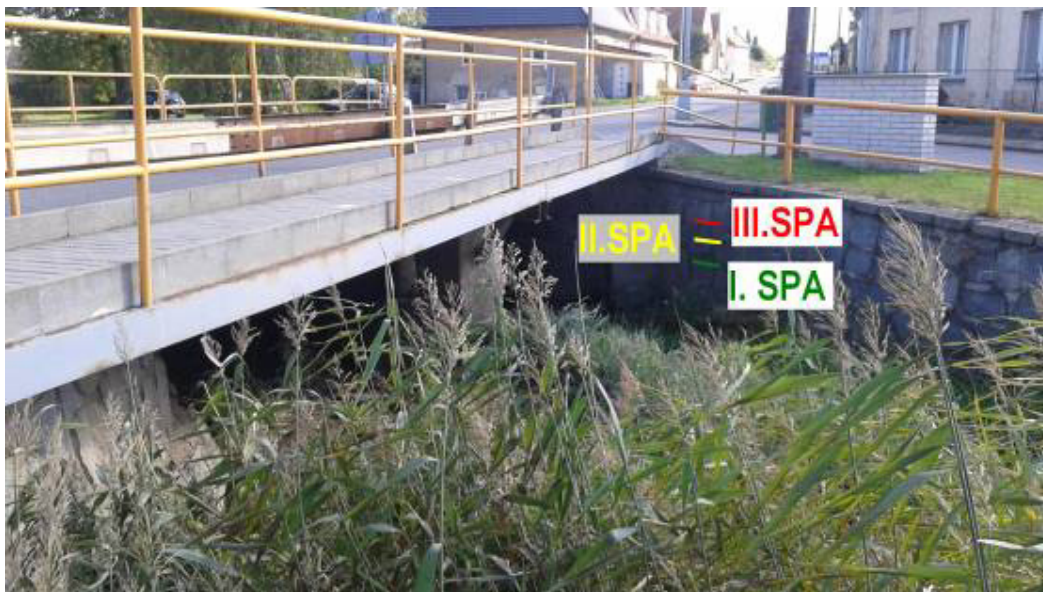
Obr. 3.6 Umístění značek stupňů povodňové aktivity Žerotínském potoce v profilu silničního mostu z návodní strany. Stanoveno na základě hydraulických výpočtů.
