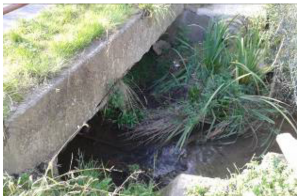
Obr. 5.2.27 Skalský potok, vtok do mostu M4_SK, ř. km 0,42.
