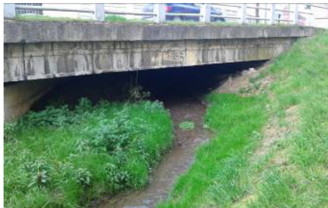
Obr. 5.2.26 Skalský potok, výtokové čelo zatrubněného úseku, M2_SK, ř. km 0,143.
