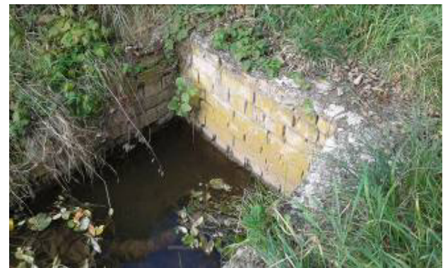
Obr. 5.2.10 Odběrný obj. nad Jamborovým prahem, pohled do usazovacího prostoru odběrného objektu ze kterého vede přívodní potrubí do zásobní nádrže.
