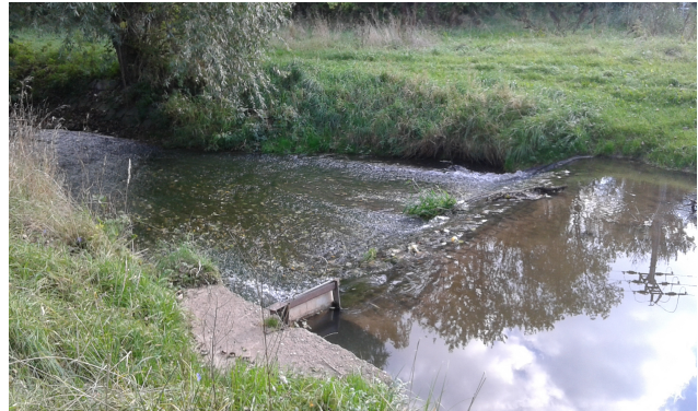
Obr. 5.2.8 Zlonický potok ř. km 15,90, pohled z levého břehu na vzdouvací obj. Jamborového prahu zajišťuje kótu hladiny pro odběr vody do Zásobní nádrže Kobylníky.
