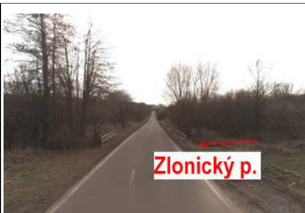
Obr. 5.2.13 Silniční most M5_ZL, přes silnici č. 237, ř. km 17,23
