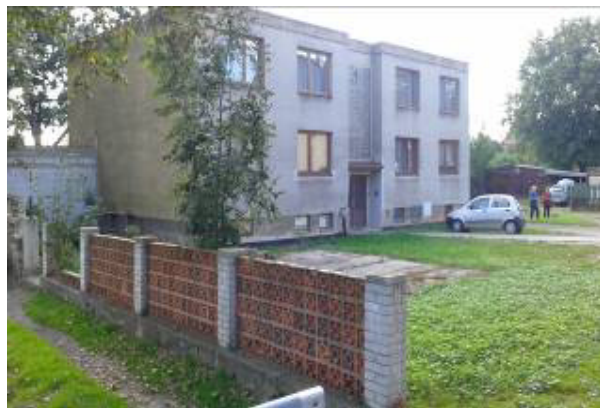
Obr. 5.2.25 Skalský potok, ohrožený objekt v pravé inundaci č. p. 13.
