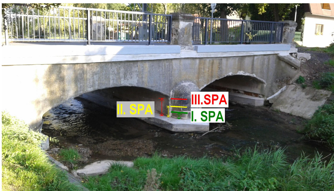
Obr. č. 3.3 Umístění značek stupňů povodňové aktivity na Zloninském potoce v Pálečku. Stanoveno na základě hydraulických výpočtů.
