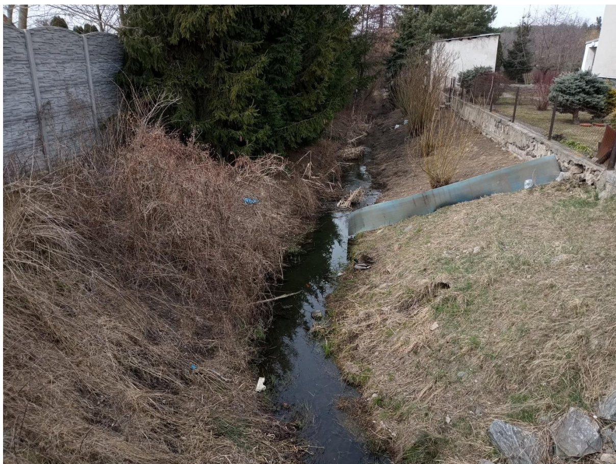
Obr. 8 Příklad bodu z priority 2 – bod 36 překážka v průtočném profilu
