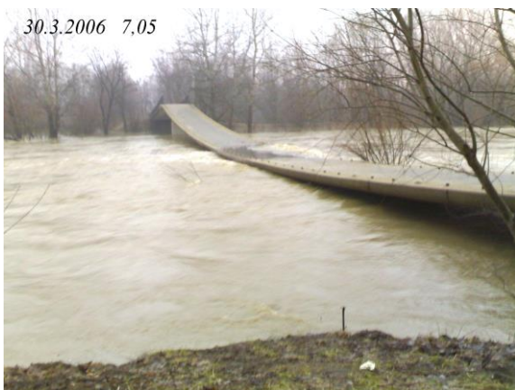
Lávka s demontovaným zábradlím
