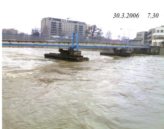
Lávka s demontovaným zábradlím
