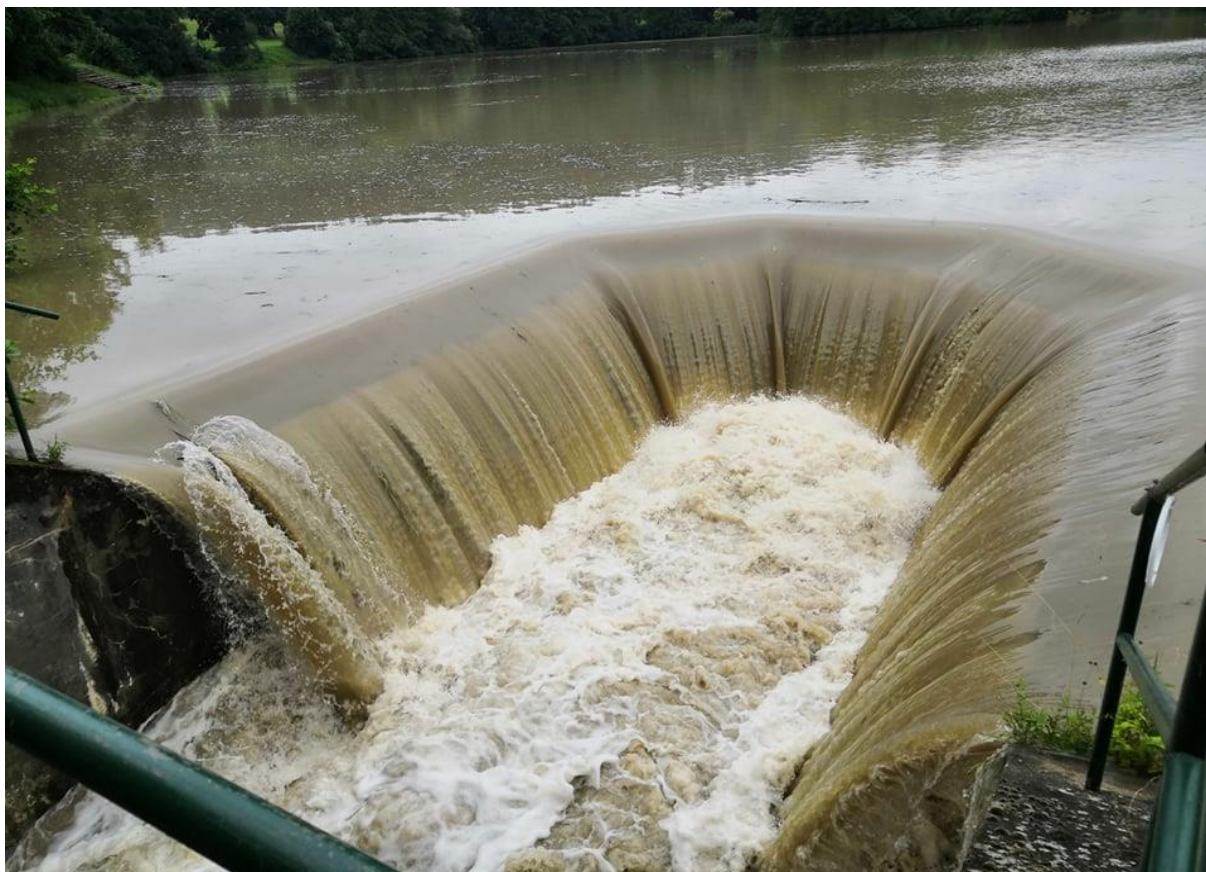
Obr. 6 Bezpečnostní přeliv rybíku Chobot
